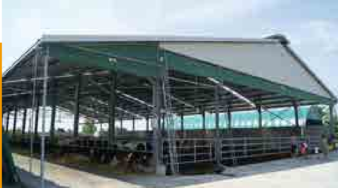
Stalla con reti frangivento per proteggere gli animali dalle correnti e dall'irraggiamento solare
