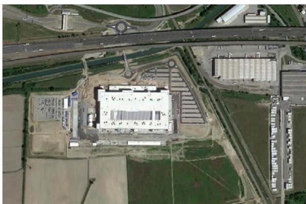
FIGURA 1 Un esempio di nuova copertura artificiale (consumo di suolo) di circa 23 ettari a Novara per la realizzazione di un polo logistico. Dall'alto al basso le immagini satellitari dell'area negli anni 2020, 2021 e 2022.
