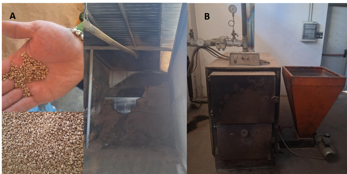
Fig. 2. I noccioli di oliva prodotti dalla cooperativa (A) e lo scaldacqua utilizzato per produrre acqua calda in loco (B).
