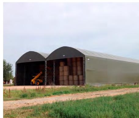
Tecnoengineering produce tunnel di copertura affiancati, utilizzabili per il ricovero foraggio, lo stoccaggio merci, il ricovero macchine e attrezzi agricoli, la protezione animali, la copertura di concimaie e/o depositi liquami. La struttura è in acciaio zincato a caldo «sendzimir» o zincato a caldo per immersione.
